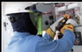
PROTECCIÓN IGNÍFUGA Arco eléctrico
