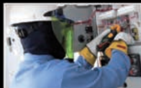
PROTECCIÓN IGNÍFUGA Arco eléctrico
